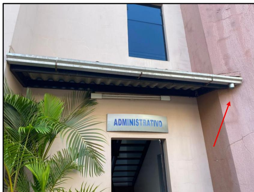
A água pluvial do telhado do acesso secundário, deverá ser substituída por descida metálica retangular e deverá seguir pela parede da edificação e ser levada até a sarjeta do asfalto (passando baixo do passeio em paver), utilizar canos de saída 75mm. Para a vazão da cobertura utilizar a medida de cano 100mm (porém em formato retangular).
