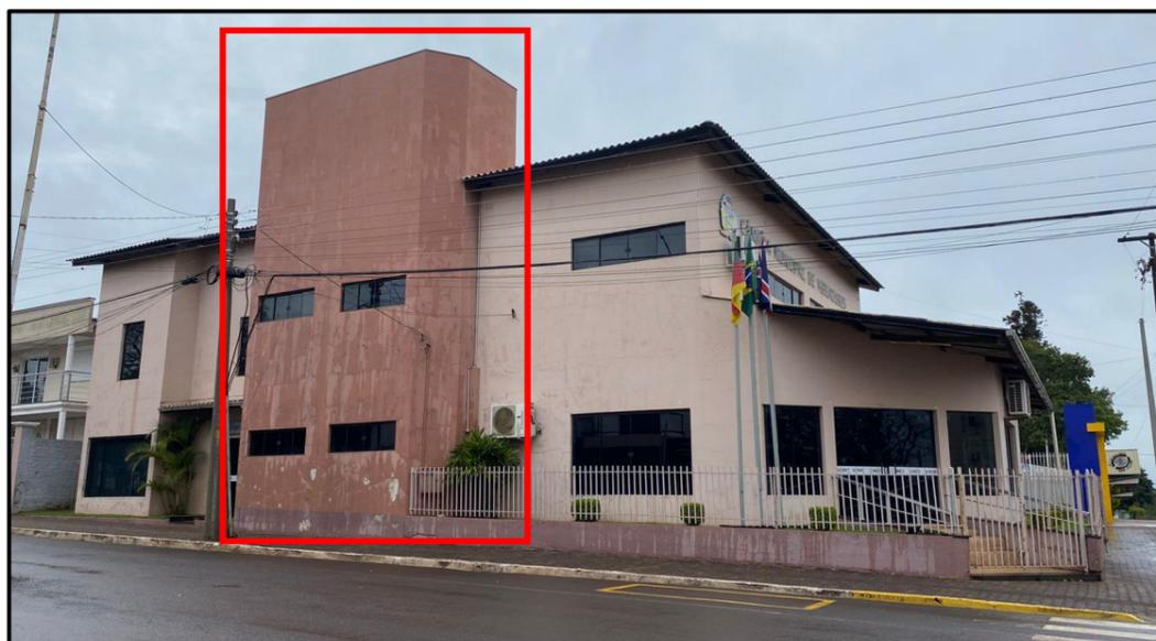
O reboco destes pontos encontra-se em estado de deterioração e desintegração, deverá ser retirado com equipamento manual, deve ser alcançado a alvenaria, ser feita a limpeza, para o recebimento no novo chapisco, argamassa de assentamento e revestimento cerâmico. O revestimento será do tipo pedra Miracema (tonalidade clara), que deverá ser trazidas amostras até o local da obra para a escolha.
