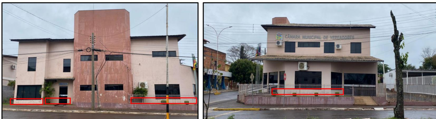
O reboco destes pontos encontra-se em estado de deterioração e desintegração, deverá ser retirado com equipamento manual, deve ser alcançado a alvenaria, ser feita a limpeza, para o recebimento no novo chapisco, reboco, massa acrílica externa, fundo preparador e pintura.
